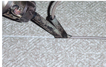
溶接部の施工状況
